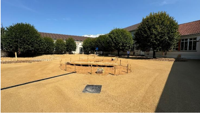
Exemple enrobé clair perméable chantier en cours Ecolé Gambetta de Saint Dizier
